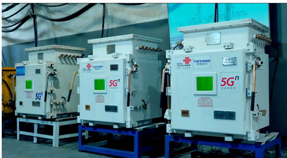
8234综采工作面支架5G基站及其天线
