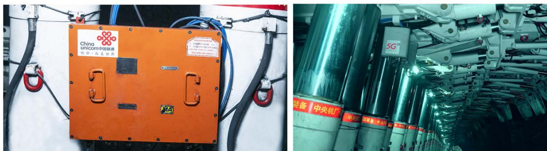
图 1 井下环网交换机与 5G 布置
