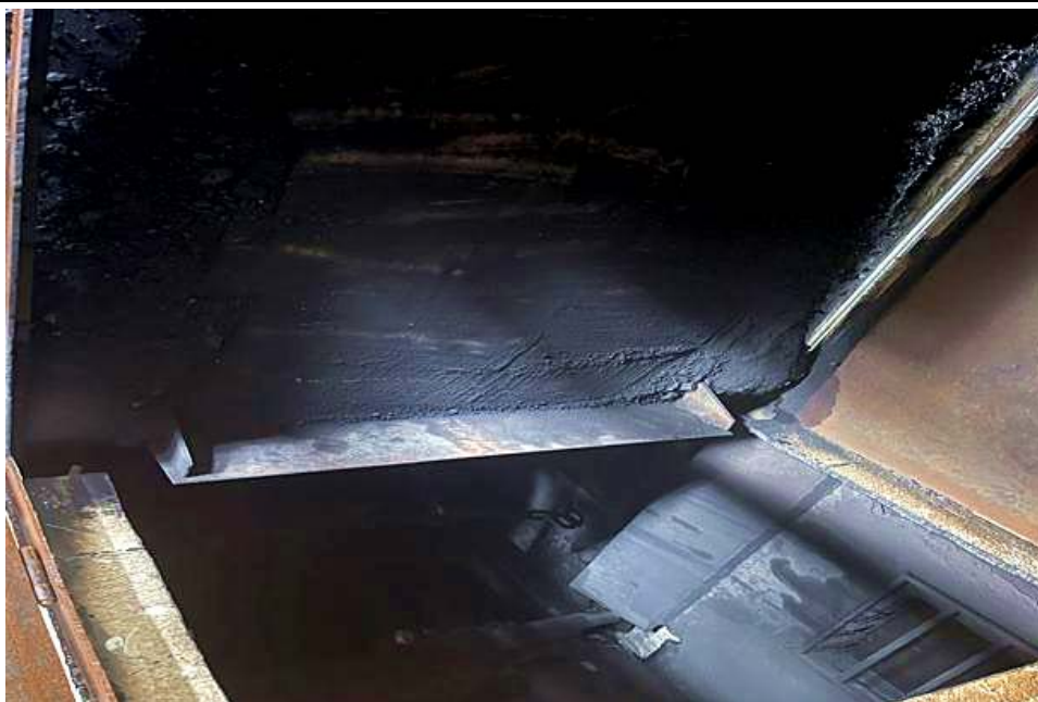
图6 胶带前端煤样采取装置
