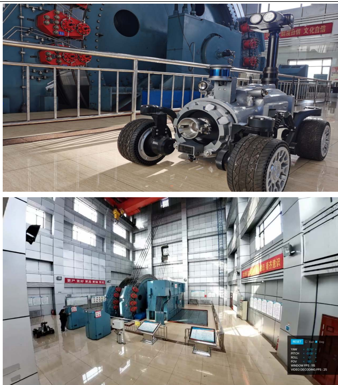
图2 主井巡检机器人
