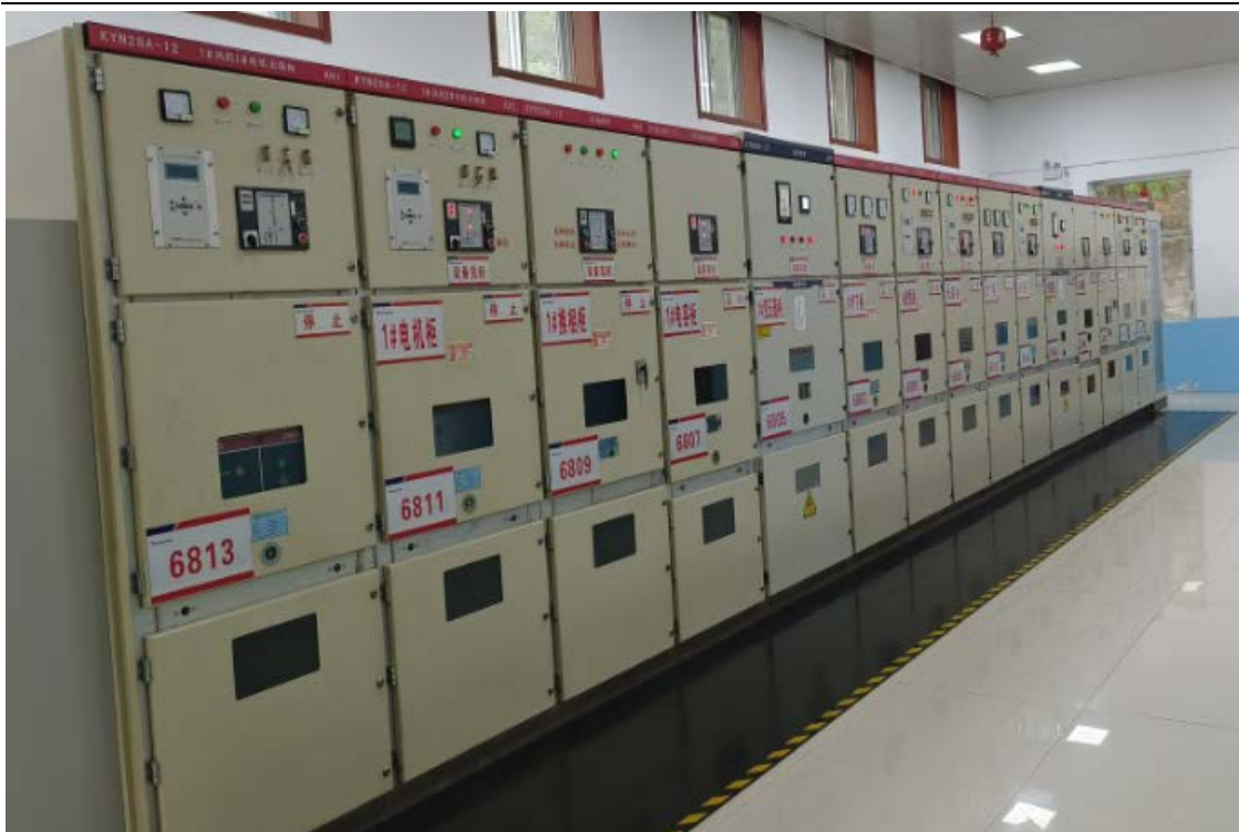
图3 主通风机配电系统
