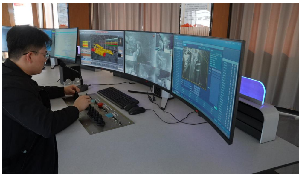
图 1 智能掘进地面集控中心
