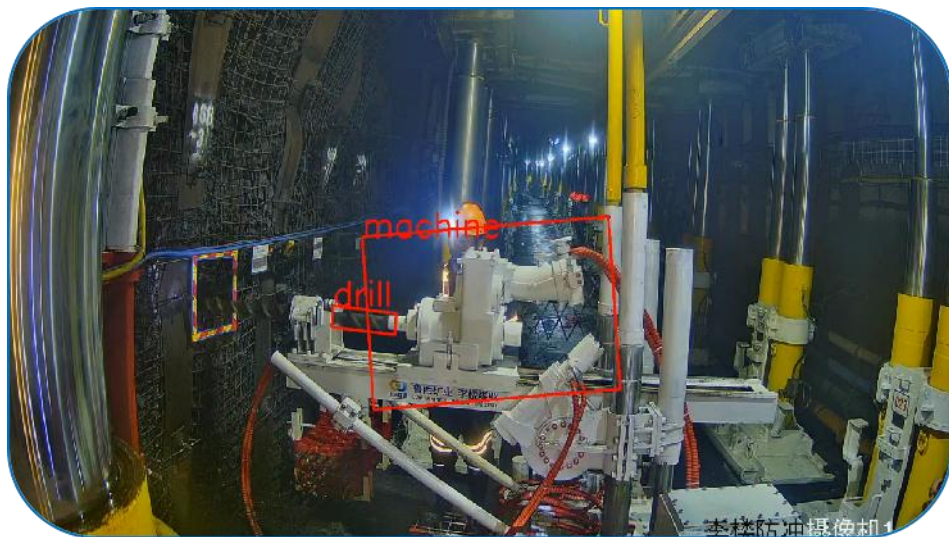
视频AI监管防冲工程施工
