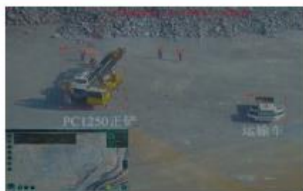
矿山爆破区域警戒及监控
